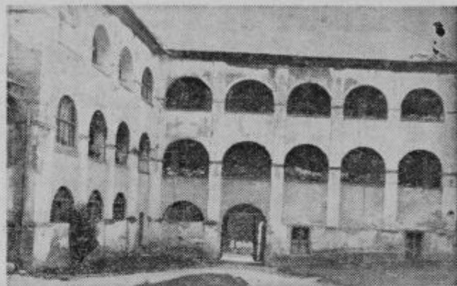
Studeniški samostan čaka obnove
