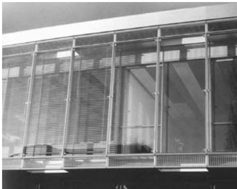
Slika 12: Model jaškaste vzorčne fasade za nebotičnik, Düsseldorf [Oesterle, 1998]
