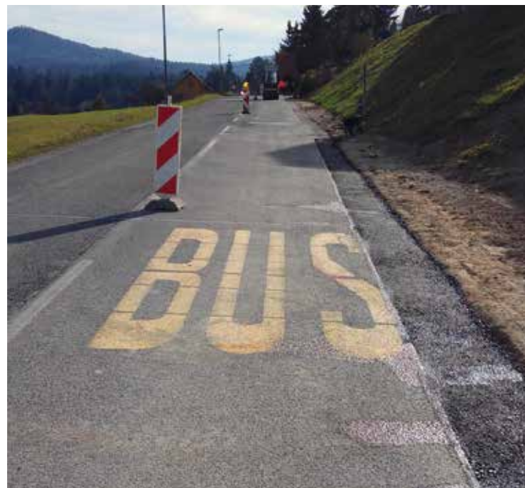
Sanacija vodovodnega omrežja na delu Golega
