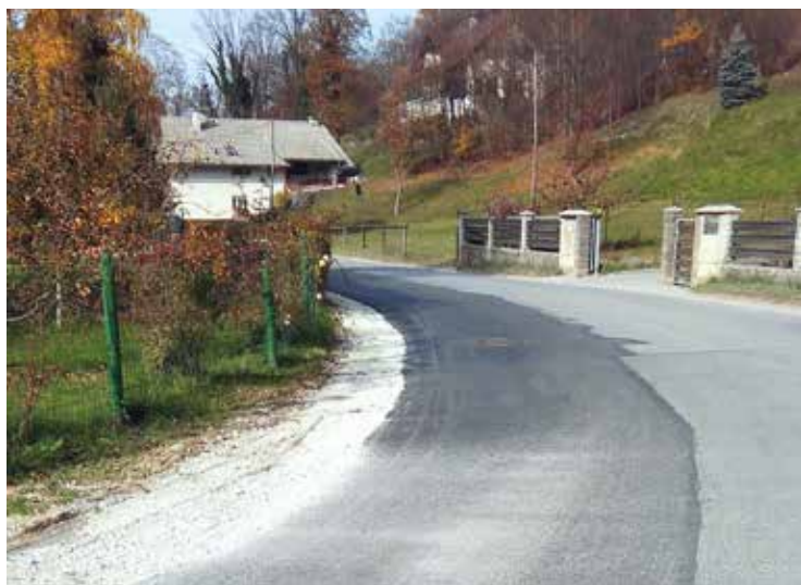
Del Iške vasi z novo kanalizacijo
