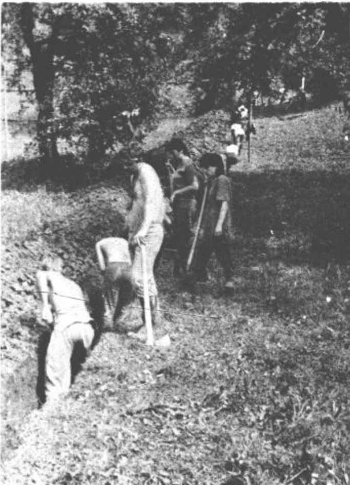
Na delovnih akcijah pri izgradnji vodovoda so krajanje pridno vihteli krampe in lopate
