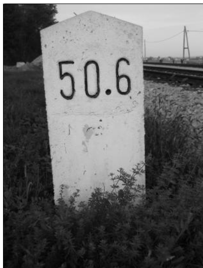
Slika 14: Označba km lege. Ob progi je na vsakih 100 m en kamen. Kamen na sliki označuje km lego 50,6 km od začetka proge, tj. od Pragerskega. Foto: Franc Krnjak, Središče, 2. 10. 2008.
