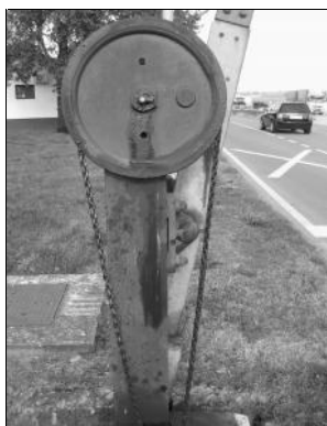
Slika 11: Mehanizem za zapornice na postaji Središče. Foto: Franc Krnjak, Središče 2. 10. 2008.
