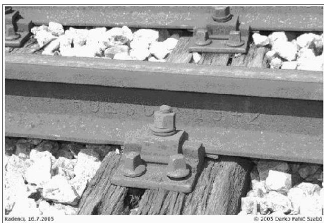
Slika 13: Tirnica, vgrajena leta 1942, je še vedno vgrajena na progi Ljutomer–Gornja Radgona in po njej poteka promet vlakov s hitrostjo do 60 km/h. Vir: http://www.vlaki.net .
