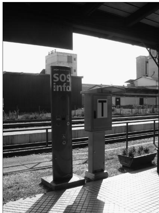
Slika 15: Telefon in SOS naprava na postaji Ljutomer za potnike, ko postaja ne bo imela prometnika. Trenutno vodi promet vlakov dispečer daljinsko iz Maribora, prometnik je le v dnevnem času, ker še ni zgrajen podhod za potnike. Foto: Franc Zemljič, Ljutomer, 12. 8. 2008.
