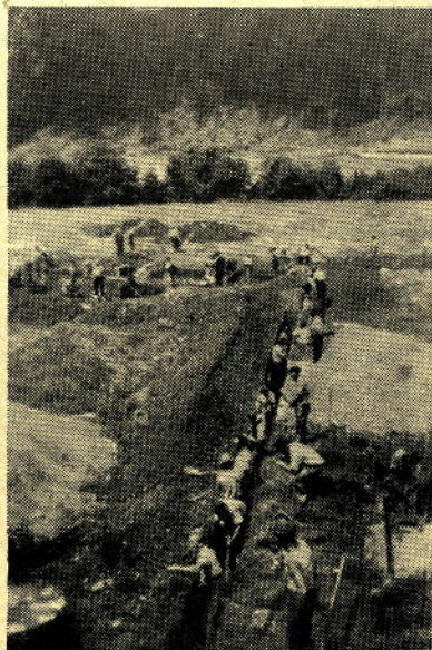
Začetek dela za zadružni dom
