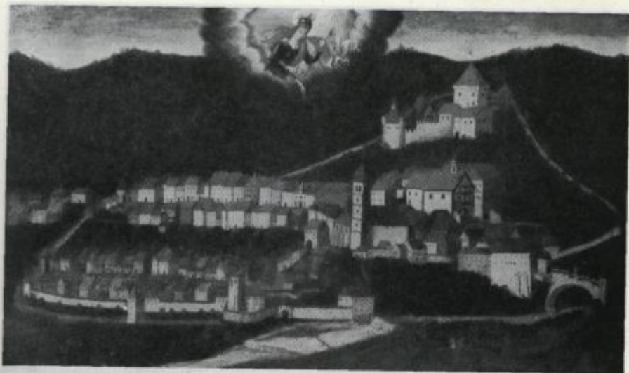
Sl. 18. Požar na Lontrku 1698
