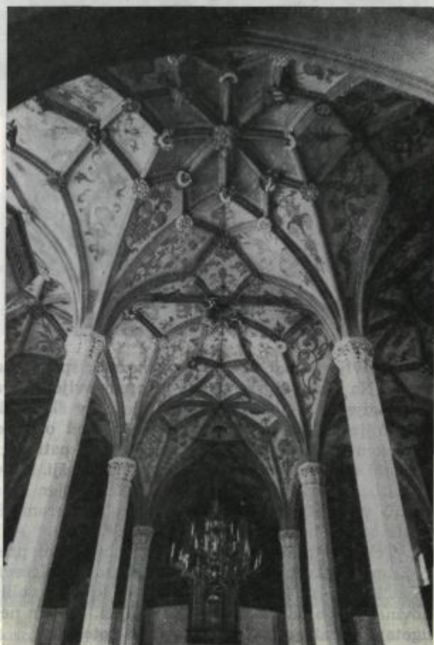
Sl. 33. Sklepniki na stropu šentjakobske cerkve v Škofji Loki, ki predstavljajo posamezne loške ceha
