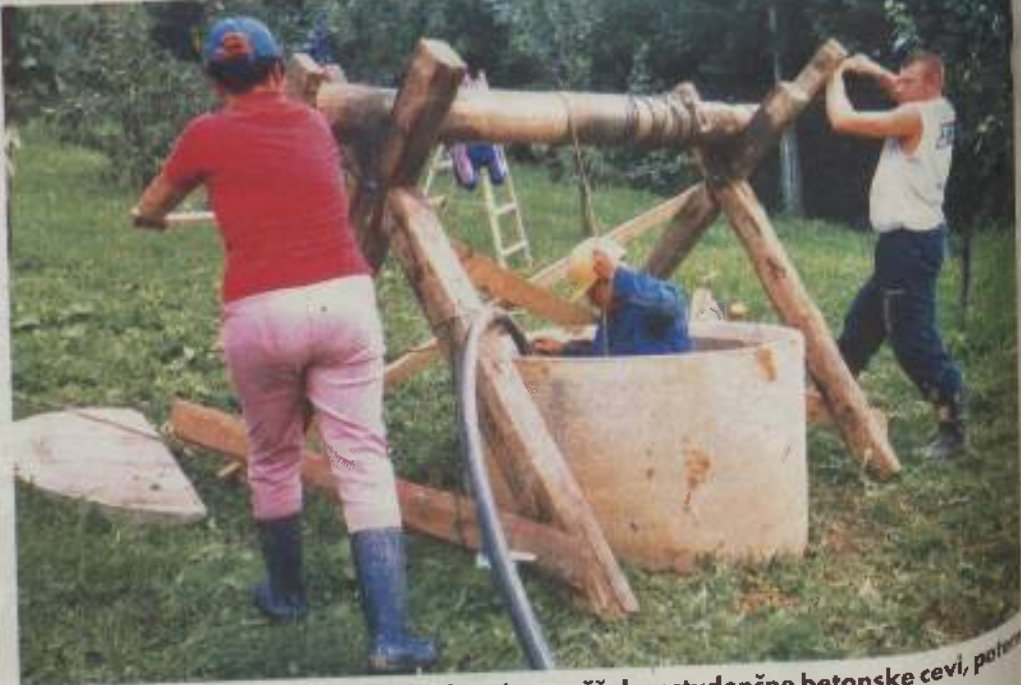
Takole sta me žena in brat pred nedavnim spuščala v studenčne betonske cevi, potem ko sem seveda najprej določil pravo mesto za »vretino«.
