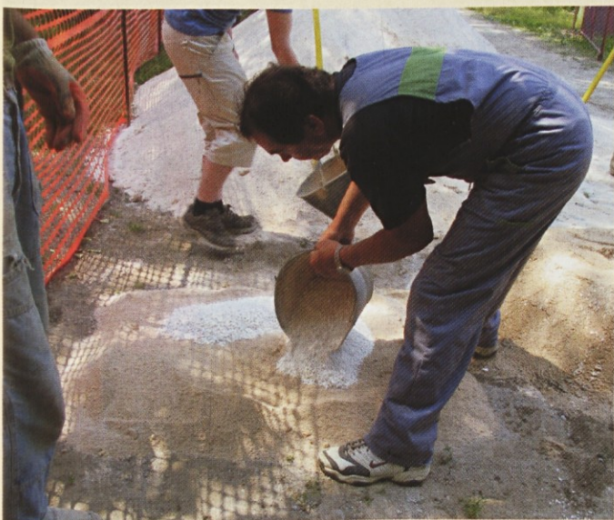
Delavnica zidar, restavratorski sodelavec: priprava apnene malte za zidanje
