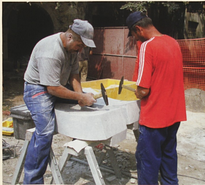
Delavnica kamnosek, restavratorski sodelavec: klesanje elementov portala
