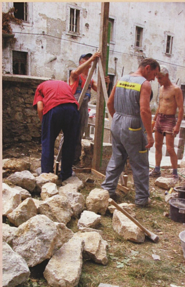
Delavnica zidar, restavratorski sodelavec: priprava za zidavo kamnitega zidu
