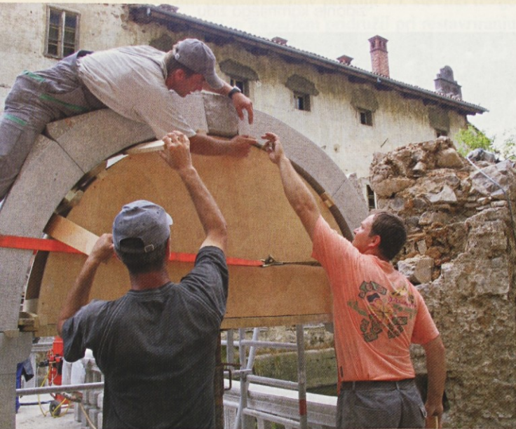
Delavnica kamnosek, restavratorski sodelavec: montaža portala
