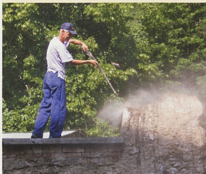
Priprava na restavratorski poseg, čiščenje ohranjenih delov
