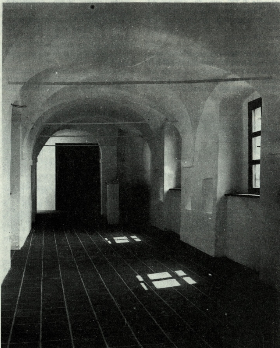
Obnovljena obrambna galerija
