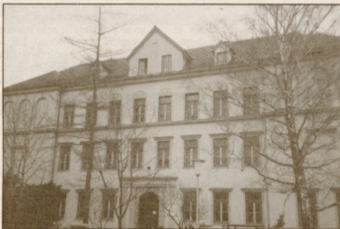
Šolsko stavbo na Vošnjakovi 10 so morali zaradi dotrajanih stropov izprazniti.
