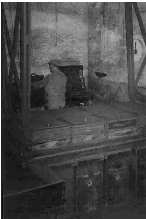
Notranjost prve sortirnice z nihajno sejalno napravo, v katero so vloženi predali, na katerih so pritrjena sita.
