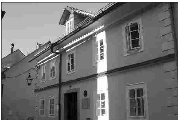
Rojstna hiša Frana Albrehta v Kamniku (Foto: Janez Bergant)
