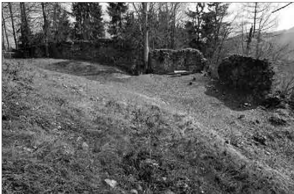
Pogled na ostanke vzhodnega dela zunanjega grajskega dvorišča z vzhodno in jugovzhodno stanico zunanjega obzidja (foto: Igor Sapač, 2016).
