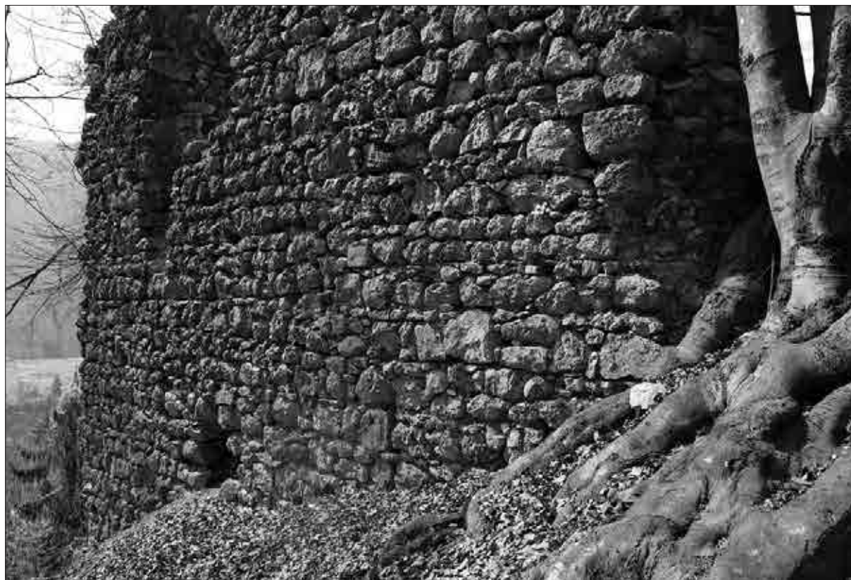
Struktura zidave na zunanji strani vzhodne stranice zunanjega grajskega obzidja (foto: Igor Sapač, 2016).
