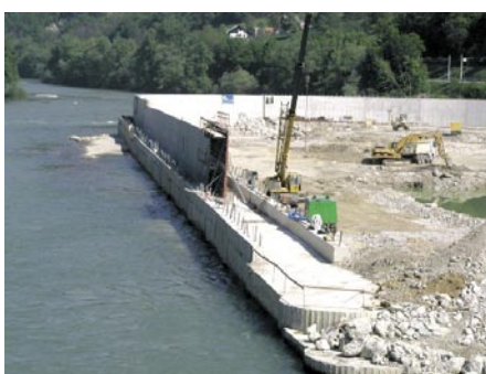
Slika 11 • Vodnjaška stena, izvedba konzole. Levo in desno od konzole sta vidni sidrni gredi za sidranje vodnjakov, v ozadju pa začasna ločna pregrada
