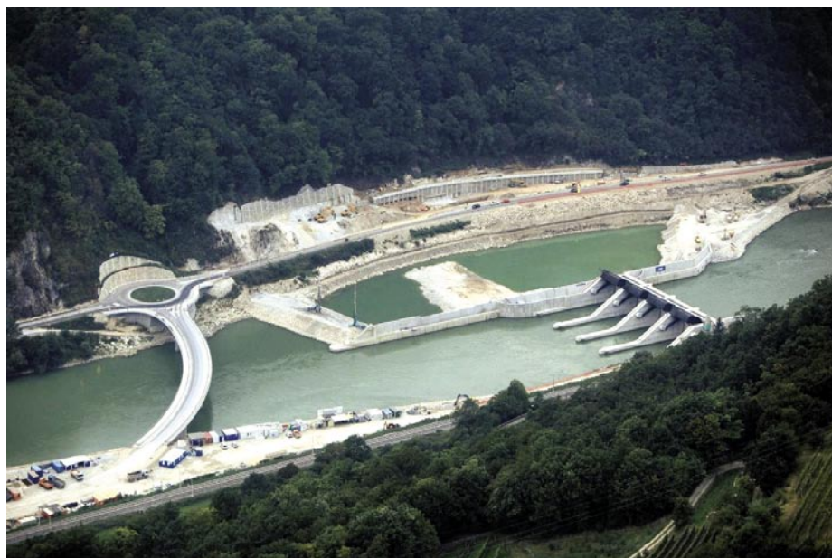
Slika 3 • Gradbišče HE Krško po zaprtju druge gradbene jame z dokončanimi štirimi prelivnimi polji in novim mostom obvoznice Krško (poletje 2009). Cesta G1-5 še poteka po stari trasi, vidna pa je izvedba del za njeno prestavitev proti pobočju
