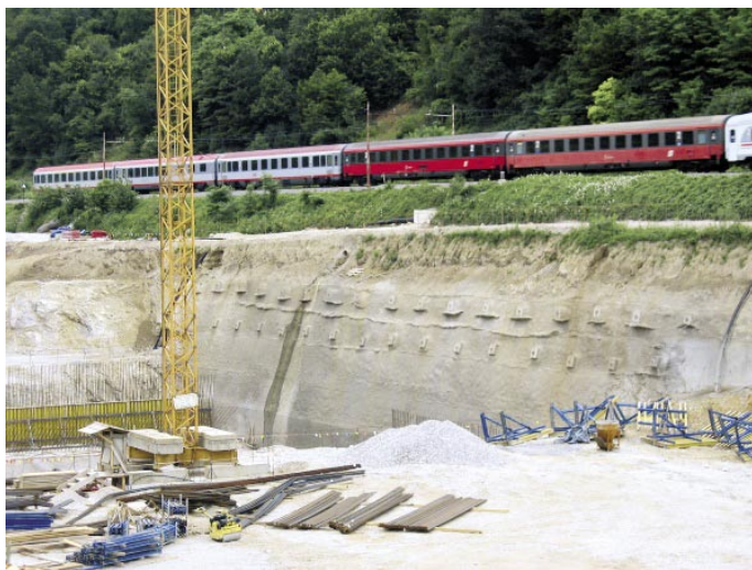
Slika 5 • Zaščita izkopa za prvo gradbeno jamo (pod železniško progo)
