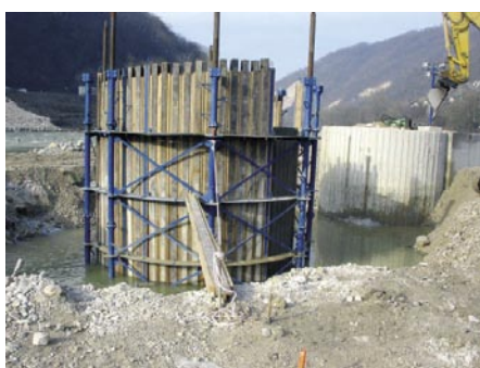
Slika 10 • Vodnjaška stena, izvedba vodnjakov; med vidnima izdelanim in opaženim vodnjakom manjka še eden. Vmesni deli med vodnjaki se prav tako opažijo in zalijejo z betonom
