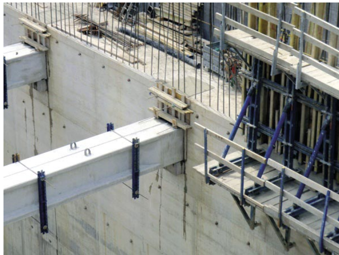
Slika 15 • Detajli stika z vertikalno in povezave nosilcev v razporah
