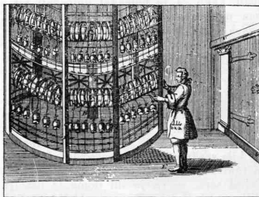
Slika 3. Veliki kolovrat (machina ali ital. filatorio)
