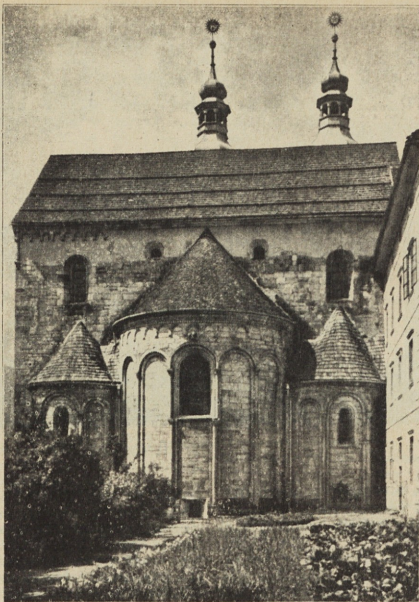
Pogled od vzhoda
