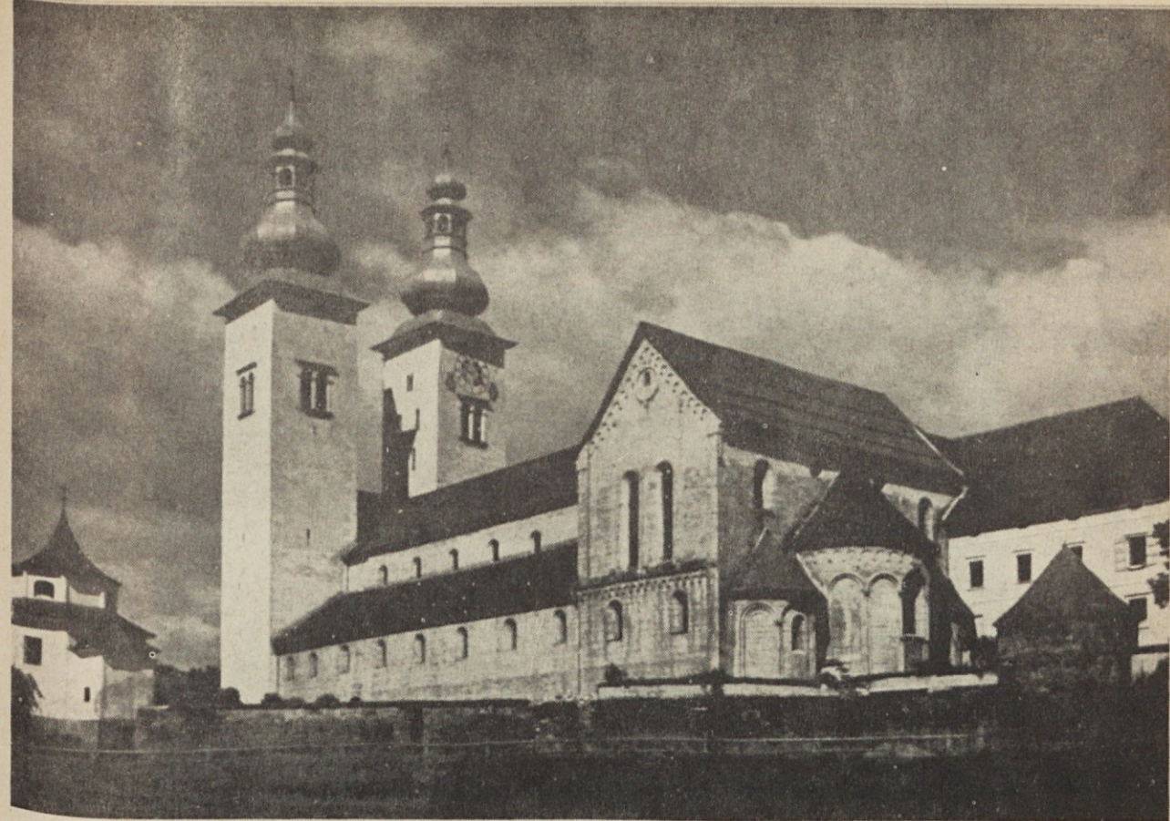
Pogled na stolnico od jugovzhoda: tri apside in samostan
