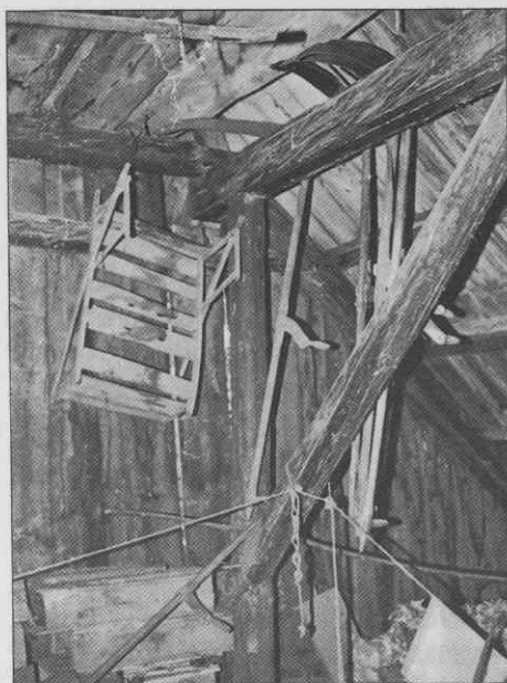
Pri Pocar: Kose zataknjene za tram ostrešja in krošnja (inv. št. P 1347) ter kranjiči na balkonskem tramu na podstrešnem prostoru na severni strani; Foto V. Knific, ZVNKD v Kranju, 1993. ♦ The Pocar farmhouse: scythes hanging on a ceiling beam, a peddler's basket and hives on the balcony beam of the northern loft; Photo by V. Knific, ZVNKD Kranj, 1993. ♦ Chez Pocar: Faux accrochées derrière la poutre de la charpente du toit, hotte (n° d'inv. P 1347) et ruches, simples, en bois, sur la poutre du balcon dans le grenier du côté nord; photo faite par V. Knific, ZVNKD à Kranj, 1993.
