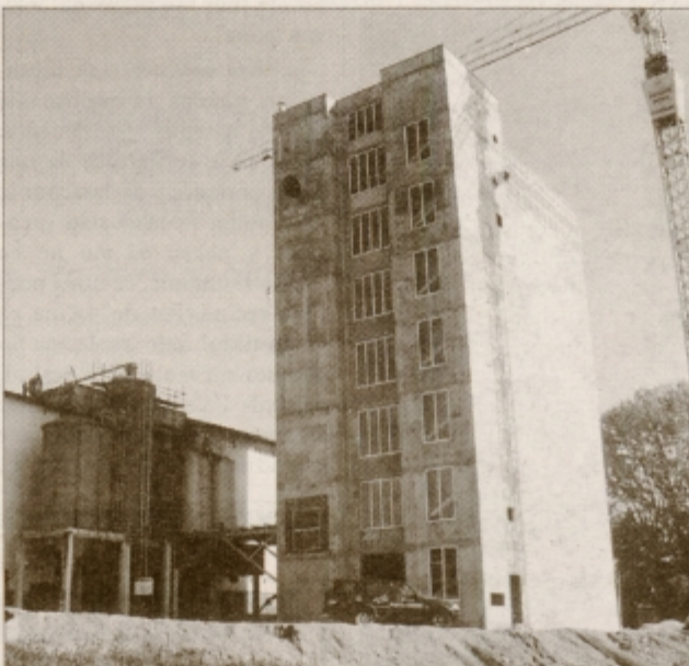
V novih silosih, ki se dvigujejo 35 m visoko, bo prostora za 5.500 ton suhega zrnja. Foto: M. Ozmec
