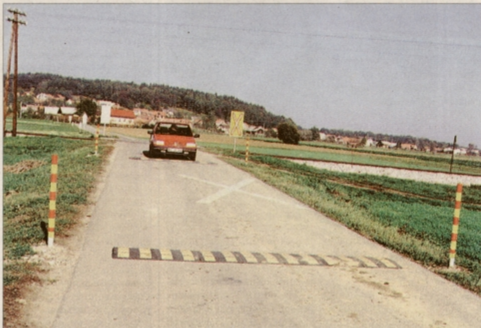
Nezavarovano križanje ceste z železnico pri Podvincih je odslej opremljeno s cestnimi ovirami in odsevnimi telesi. Foto: M.Ozmeč
