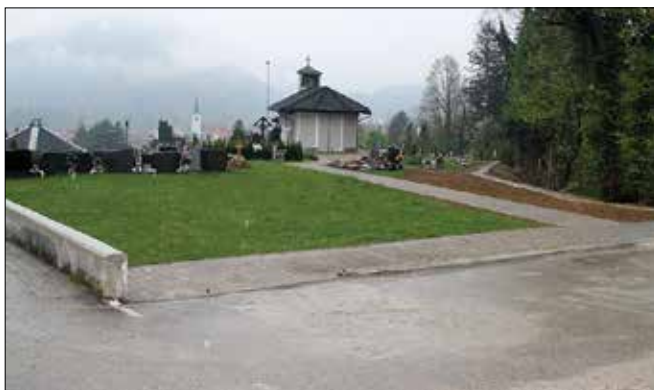
V okviru celovite sanacije bo pokopališče dobilo novo ograjo.
