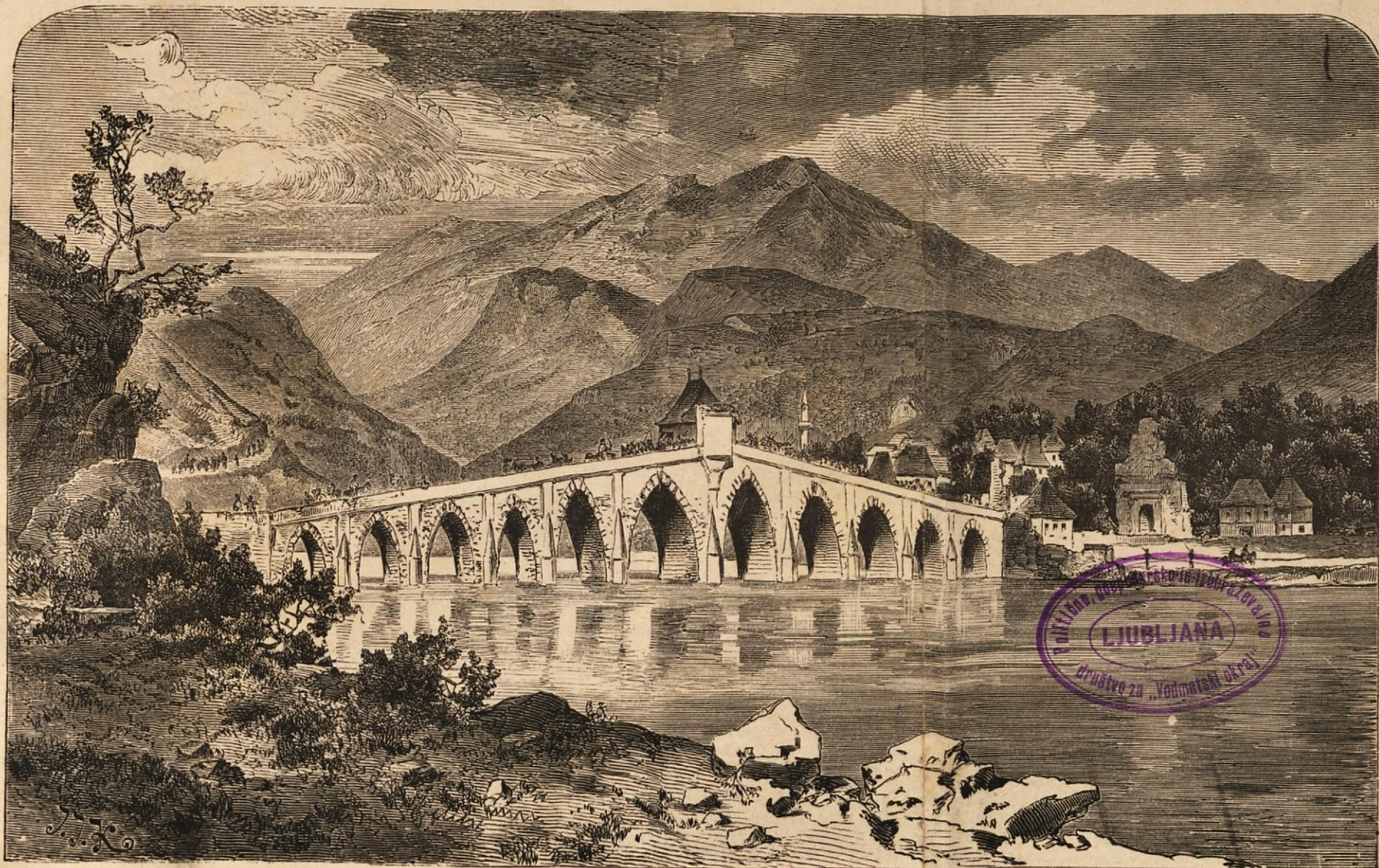
Steinbrücke über die Drina bei Višegrad.
