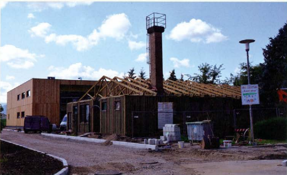
Rušenje starega objekta, za njim stoji novi, moderen Leseni škrat.
