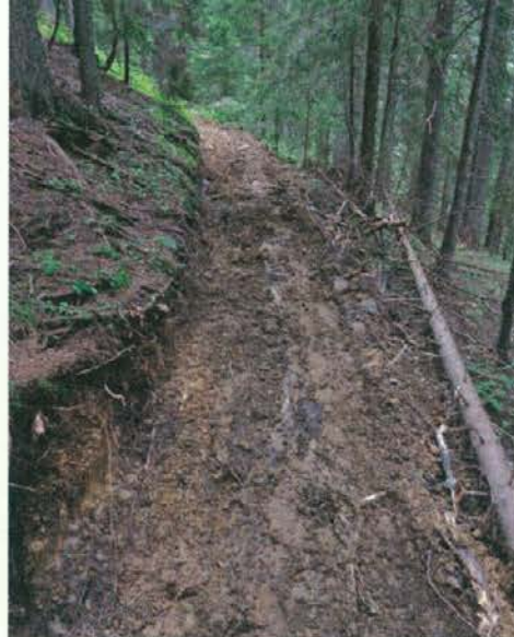
Rekonstrukcija pešpoti od Bukovnika proti Grohatu Foto: Igor Radovič
