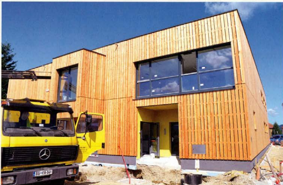
Vzhodni del objekta z izhodnimi vrati
