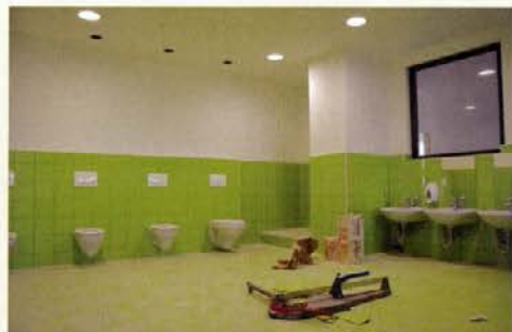
Zaključna dela v prostorih za sanitarije
