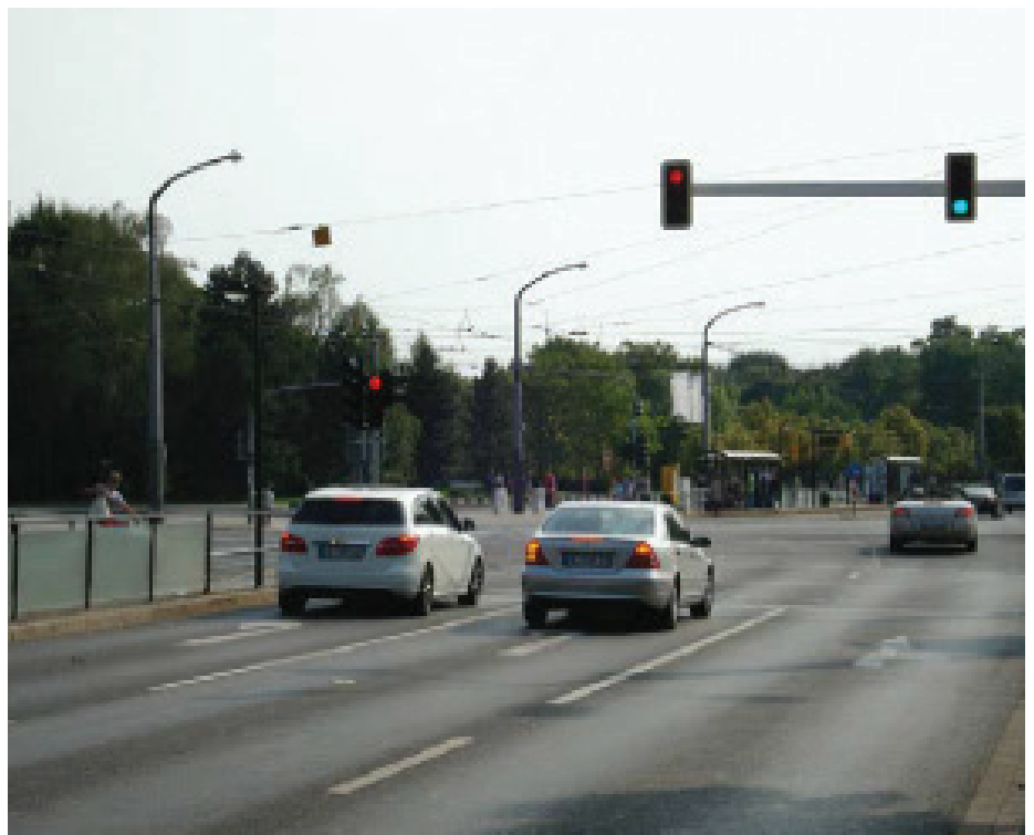
Slika 2 • Primer ločene signalizacije za levo in desno zavijanje v nivojskem križišču (z ločenimi fazami intervala zelene luči).
