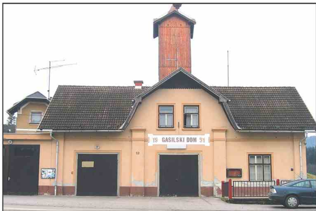
Izgradnja novega doma krajanov in gasilskega doma so zaradi predragega zemljišča prestavili v neposredno bližino stare šole v Topolšici.
