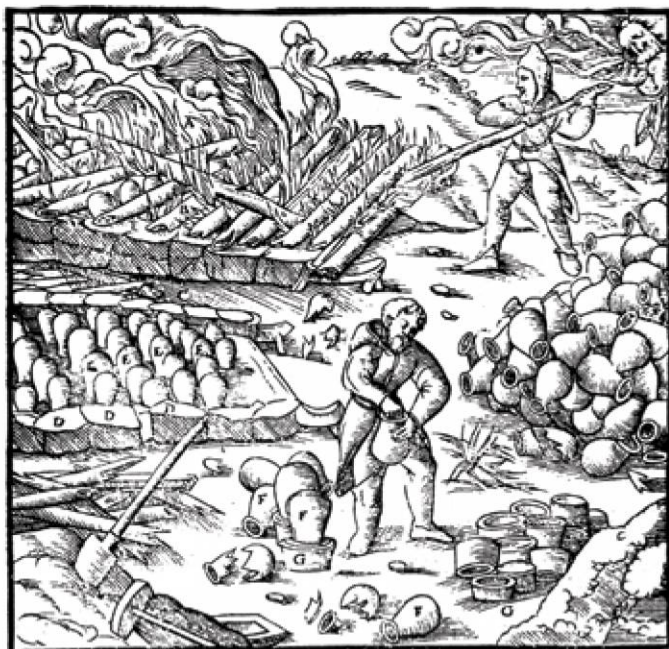
Žganje rude v lončernih posodah na prostem. (Agricola, de re metallica , 1556)
