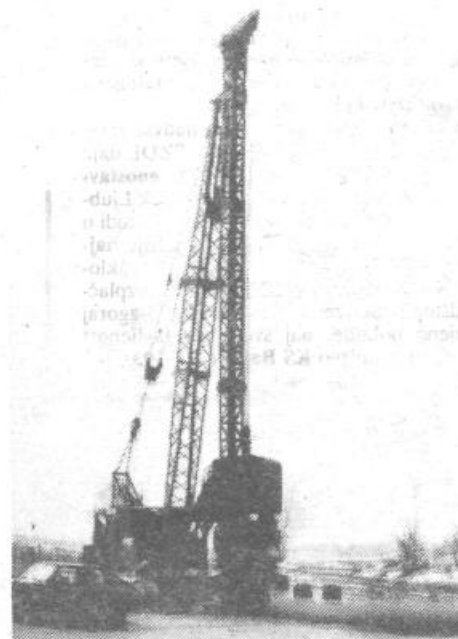
UTRJEVANJE TERENA – Na obeh straneh Ižanske ceste delavci vgrajujejo v traso do 15 metrov globoke gruščnate »kole«.
