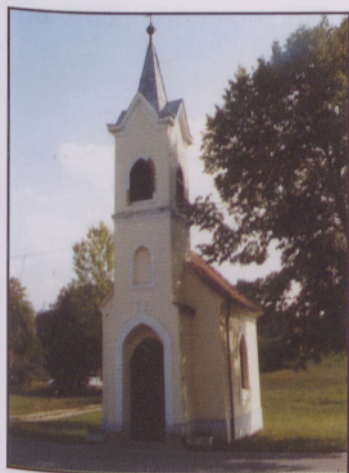
Bukovnica, kapela sv. Križa
