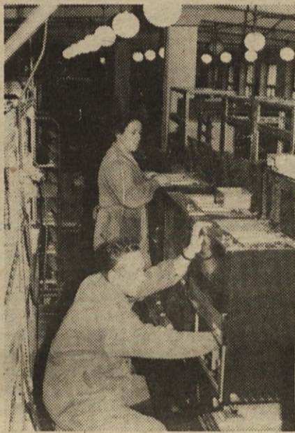
Pogled v montažo oljnih peči
