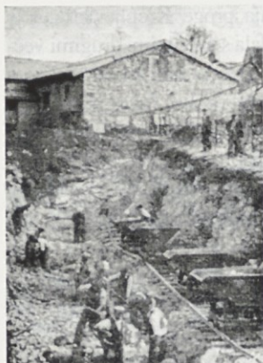
Gradnja proge Kreplje-Sežana.
