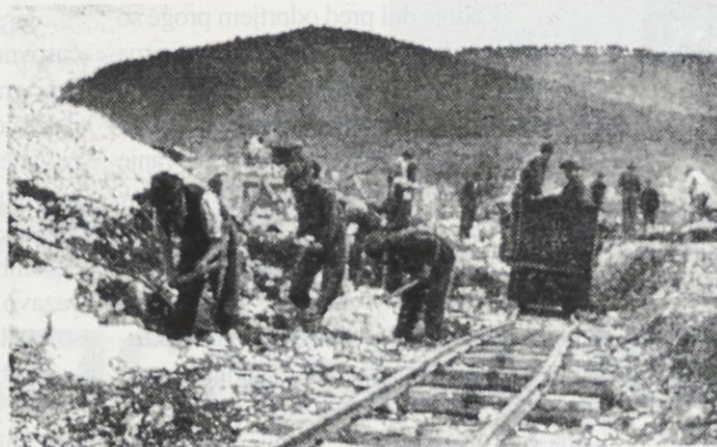
Pričetek gradbenih del v Sežani, od železniške postaje do predora
