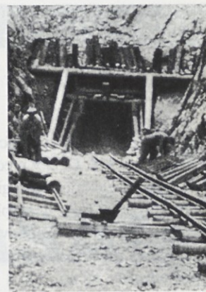
Gradnja predorovega portala v smeri Sežana
