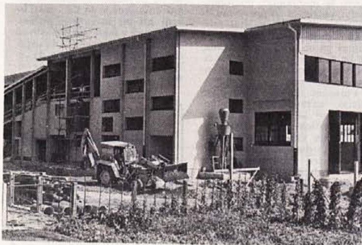
Zaključena dela v obratu plastike
