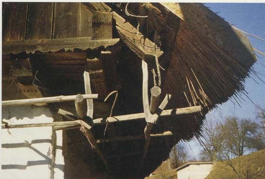
Lasigovci, konzole strešne konstrukcije; Nenavadna je lesena opora za trto.
