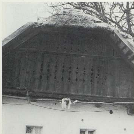
Prezračevalne line podstrešja v lesenem zatrepu svislj v Vitomarcih in Kukavi.
