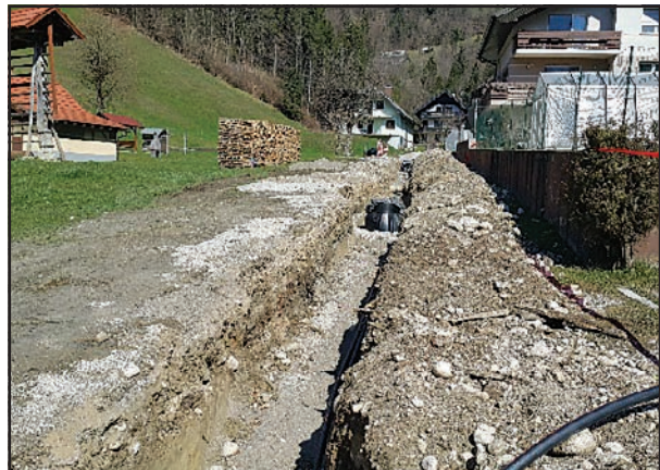
Izgradnja kanalizacije v Soteski (Arhiv Občine Kamnik)
