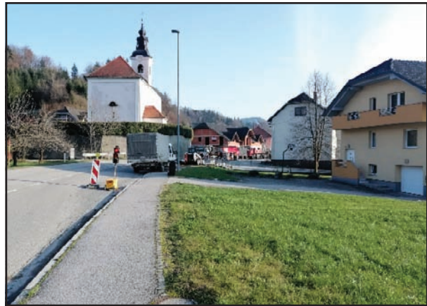
Izgradnja kanalizacije na Lokah (Arhiv Občine Kamnik)
