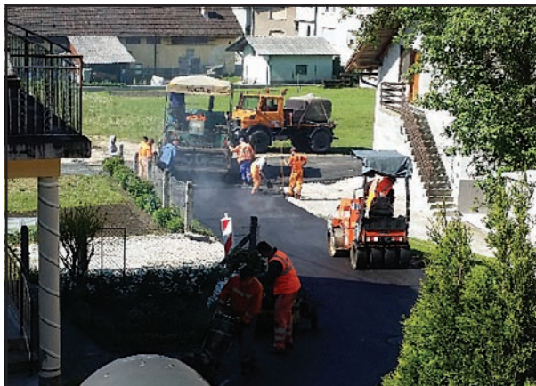
Izgradnja kanalizacije v Srednji vasi (Arhiv Občine Kamnik)
