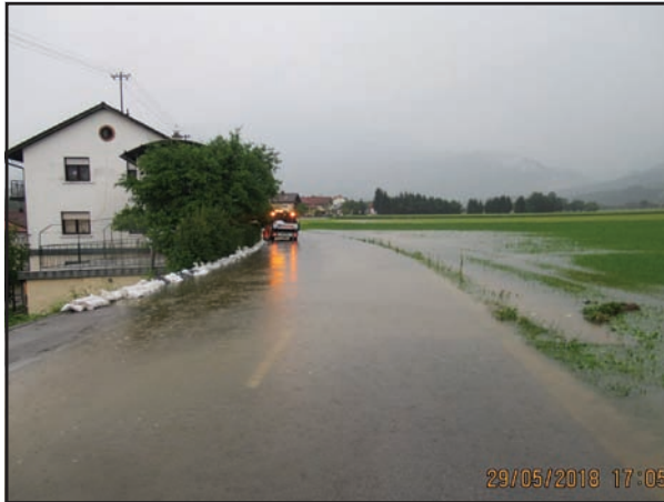
Poplavljena lokalna cesta Mekinje-Godič (Arhiv Občine Kamnik)
