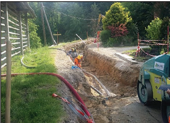
Izgradnja kanalizacije na Markovem (Arhiv Občine Kamnik)
