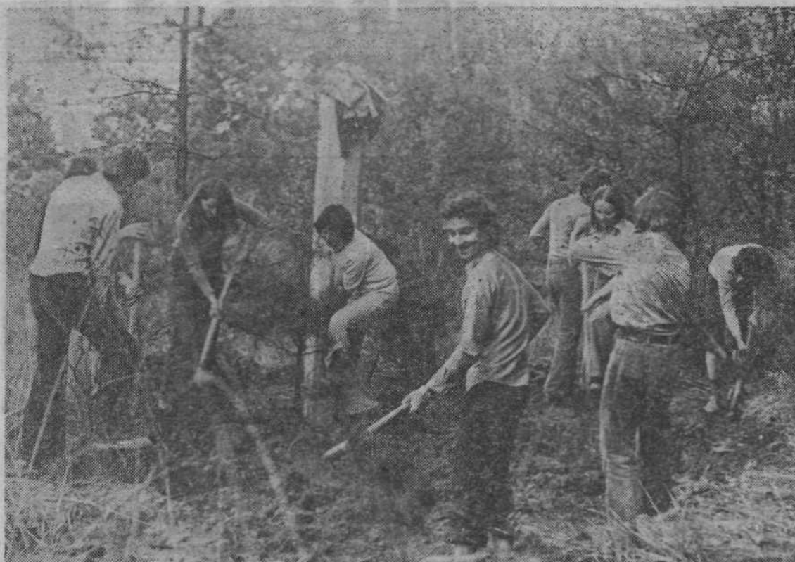
Zemlja bo kmalu odkopana, nato sledi nasinavanje peska in ostala ureditev
