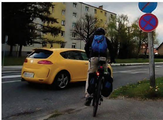
Kritična točka na koridorju A1 - nevaren nenaden zaključek kolesarskega pasu na pločniku. Foto: arhiv MKM
