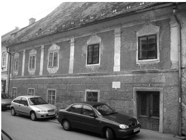
Slika 2: Prava Valvasorjeva hiša v Krškem
