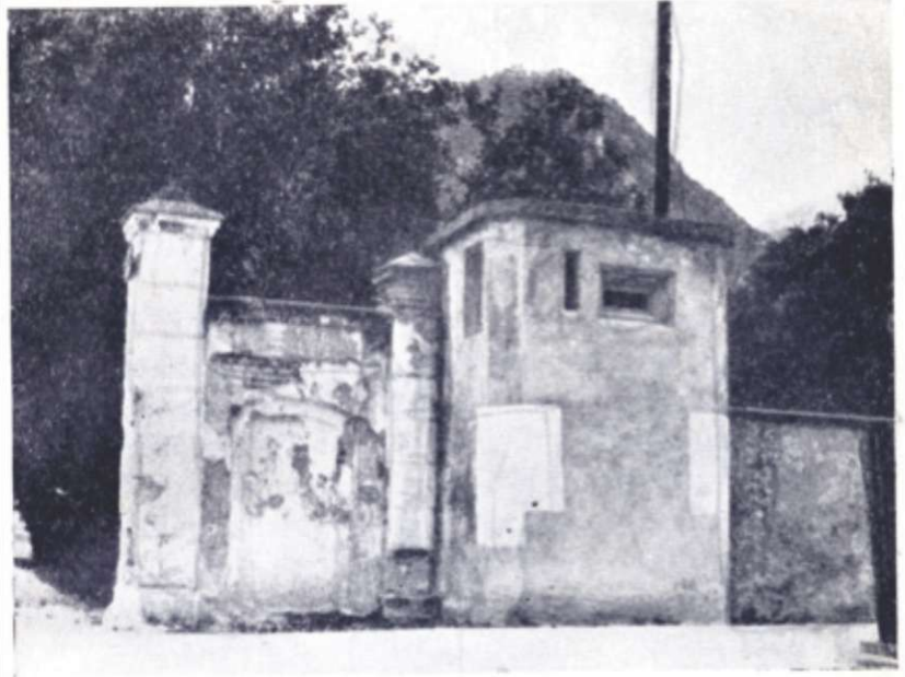
Bunker ob vhodu v kaznilnico
