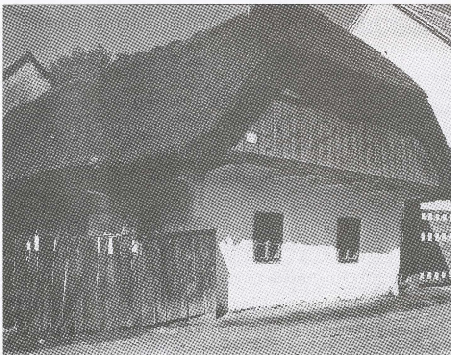
Panonska, s slamo krita hiša z značilnim pročeljem.
