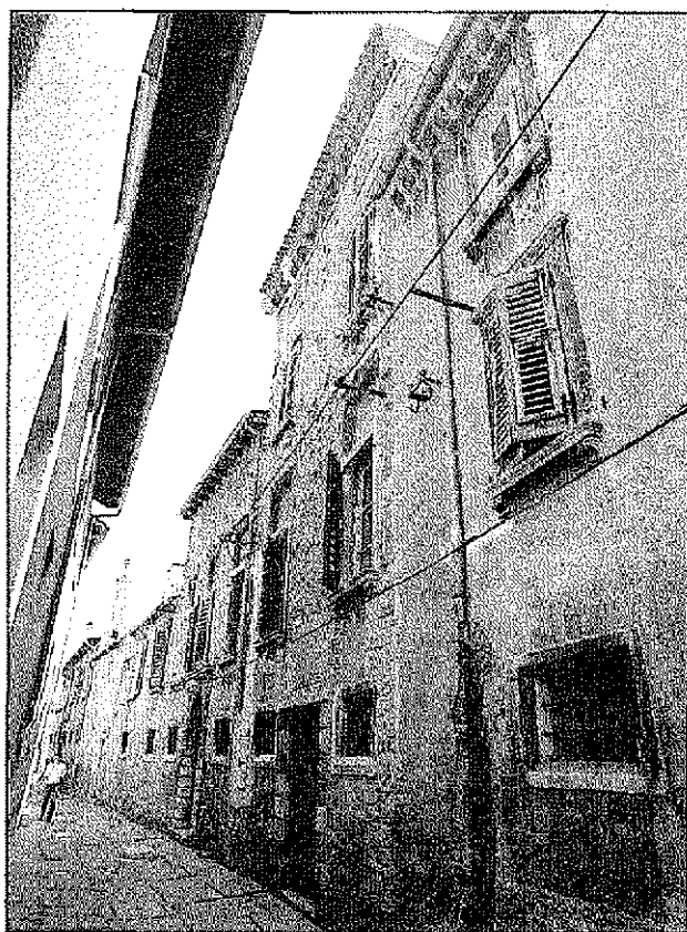
Koper, Kreljeva 6, ulična fasada (fototeka MZVNKD).
