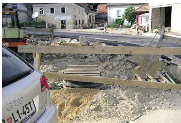
Slika 11 • Kanaliziranje Florjanskega potoka (foto: Uroš Krajnc)
