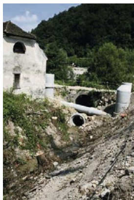
Slika 8 • Gradnja kanalizacije (foto: Ljubo Motore)
