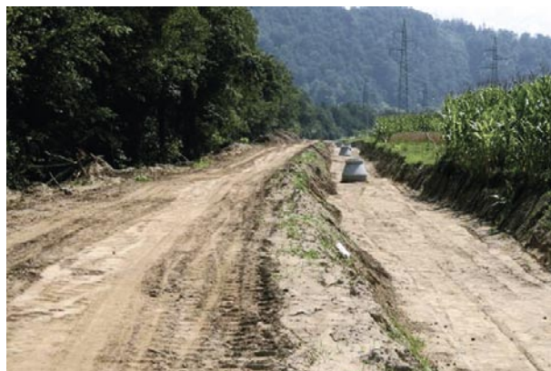
Slika 9 • Gradnja kanalizacije (foto: Ljubo Motore)
