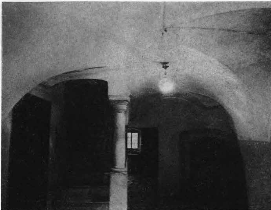
Sl. 52. Železniki – Racovnik 9, veža v pritličju Fig. 52 – Železniki – Racovnik 9, the groundfloor hall
