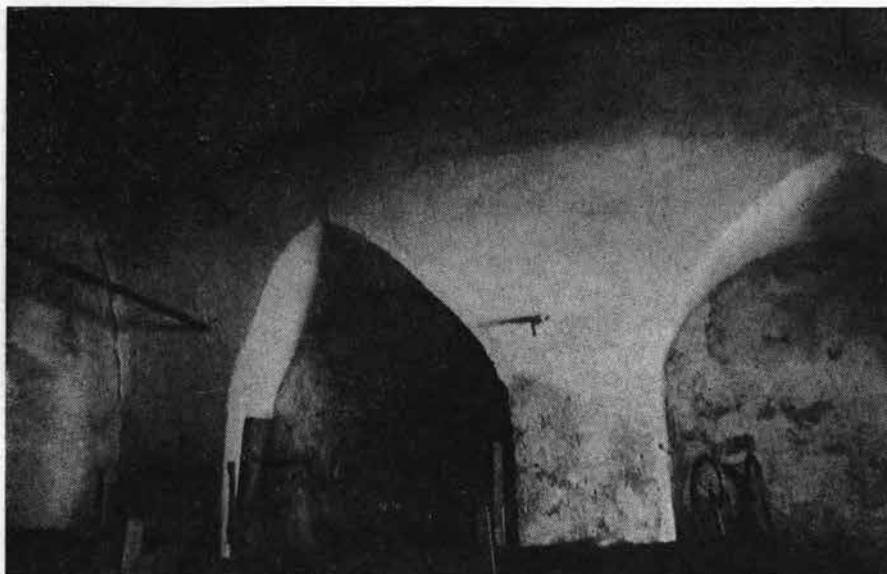
Sl. 53. Železniki – Racovnik 9, klet Fig. 53 – Železniki – Racovnik 9, the cellar
