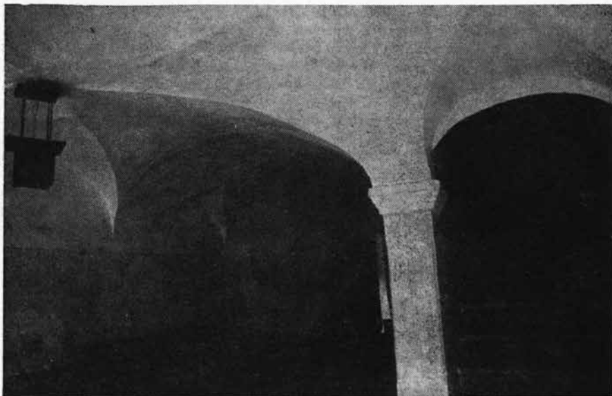
Sl. 56. Železniki – Racovnik 34, veža v pritličju Fig. 56 – Železniki – Racovnik 34, the groundfloor hall
