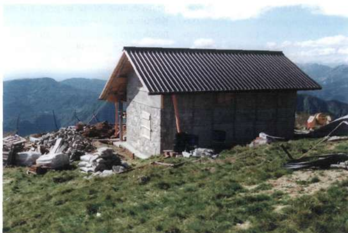
Nova koča »Dom na Matajurju« med gradnjo
