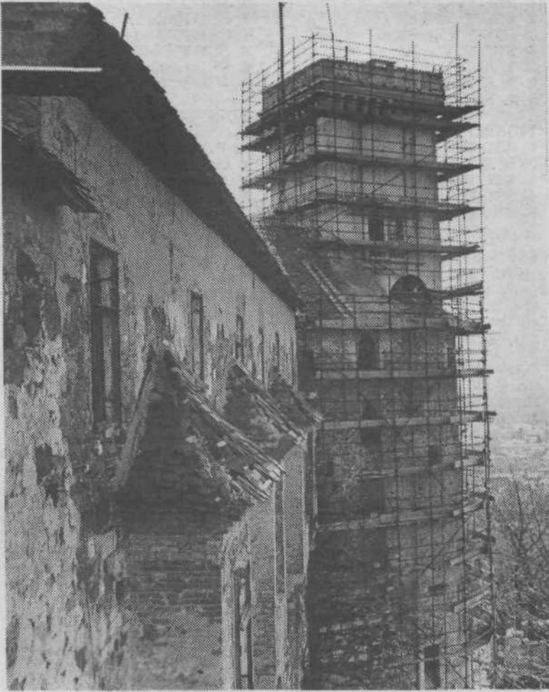
Na grajskem stolpu (H) potekajo dela za statično ureditev, na levi (G) bodo prostori za kulturne prireditve
