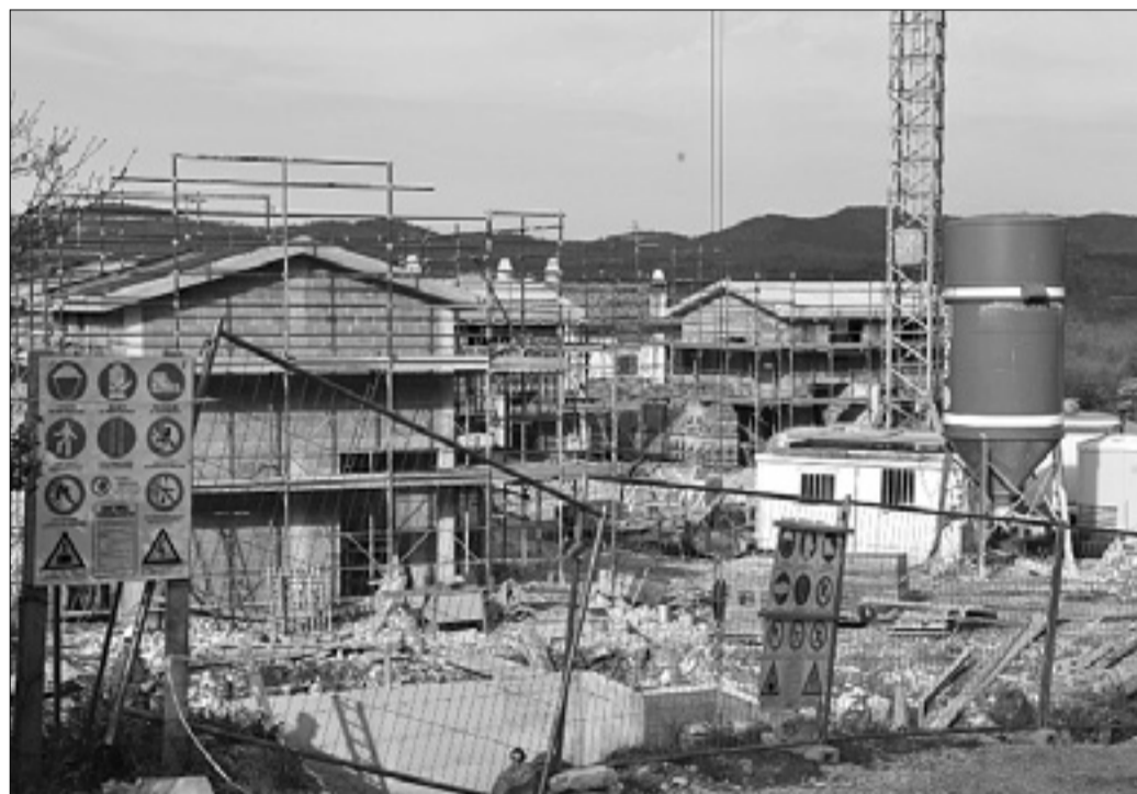
V devinsko-nabrežinski občini v tem času veliko gradijo. Posnetek je iz Križa, kjer gradijo kar nekaj novih stanovanjskih objektov
