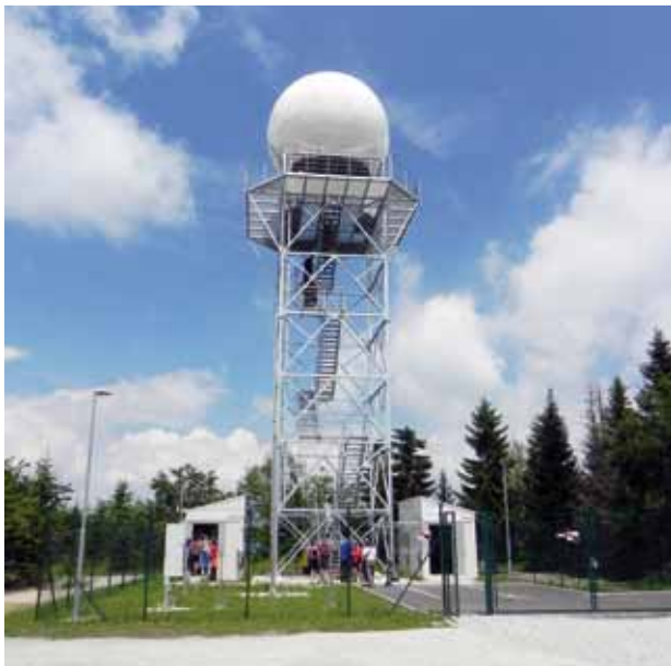
Radarski center na Pasji ravni z 22 metrskim stolpom, na katerega je nameščena 4,6 metrska radarska antena. (foto: Iztok Sinjur)
