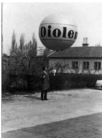
Slika 7. B. Kokalj drži na dvorišču HMZ balon premera okrog 2 m, ki je nosil v višino do 400 m sondo z doma izdelano merilno opremo. Balon so polnili z vodikom, ker za helij ni bilo denarja. (Foto: B. Kokalj)
