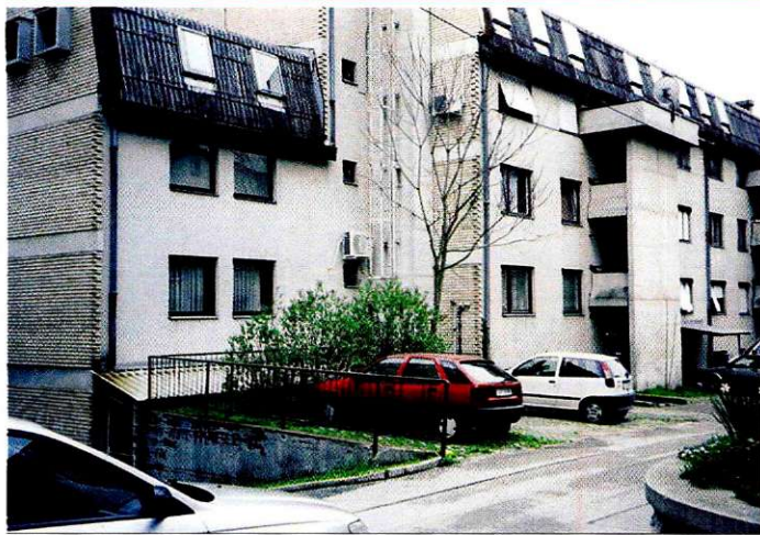
Na fotografiji je lepo vidna druga stran stanovanjske stavbe na Cesti 20. julija 2c, Zagorje, kjer ima svoj sedež GIP Beton MTO. Okna zgornjega nadstropja prizidka so zaprašena, kar pomeni, da v njem ne dela nihče. Vodstvo GIP Betona MTO ima v teh prostorih le nekaj manjših pisarn.
