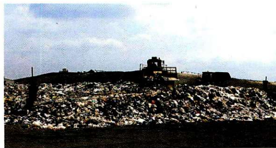
Župani južnoprimorskih občin (od Pirana, Ilirske Bistrice do Komna) so nedavno podpisali pogodbo, s katero so ustanovili konzorcij, ki bi vzpostavil enoten sistem gospodarjenja z odpadki in predvideva graditev ogromnega odlagališča odpadkov na občutljivem kraskem območju poleg že obstoječega ob cesti Sežana—Vrhpolje.
