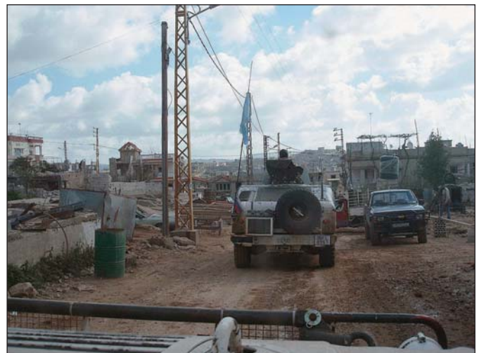
Na porušeni in uničeni ulici Libanona
