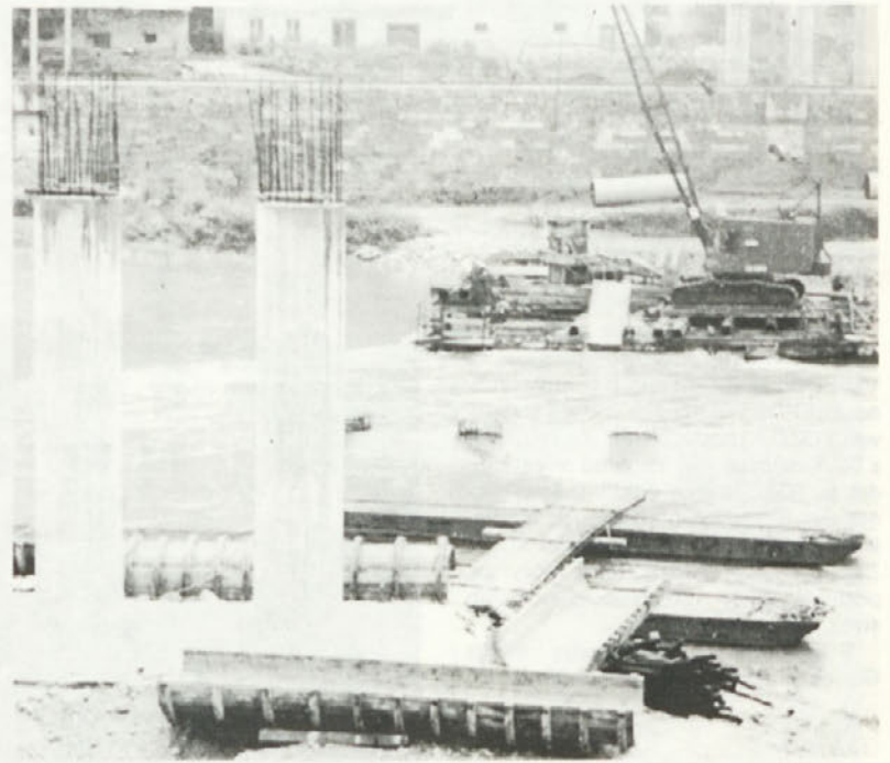
Nosilci novega mostu čez Savo v Brestanici pri Krškem (FOTO: G. Rovani)
