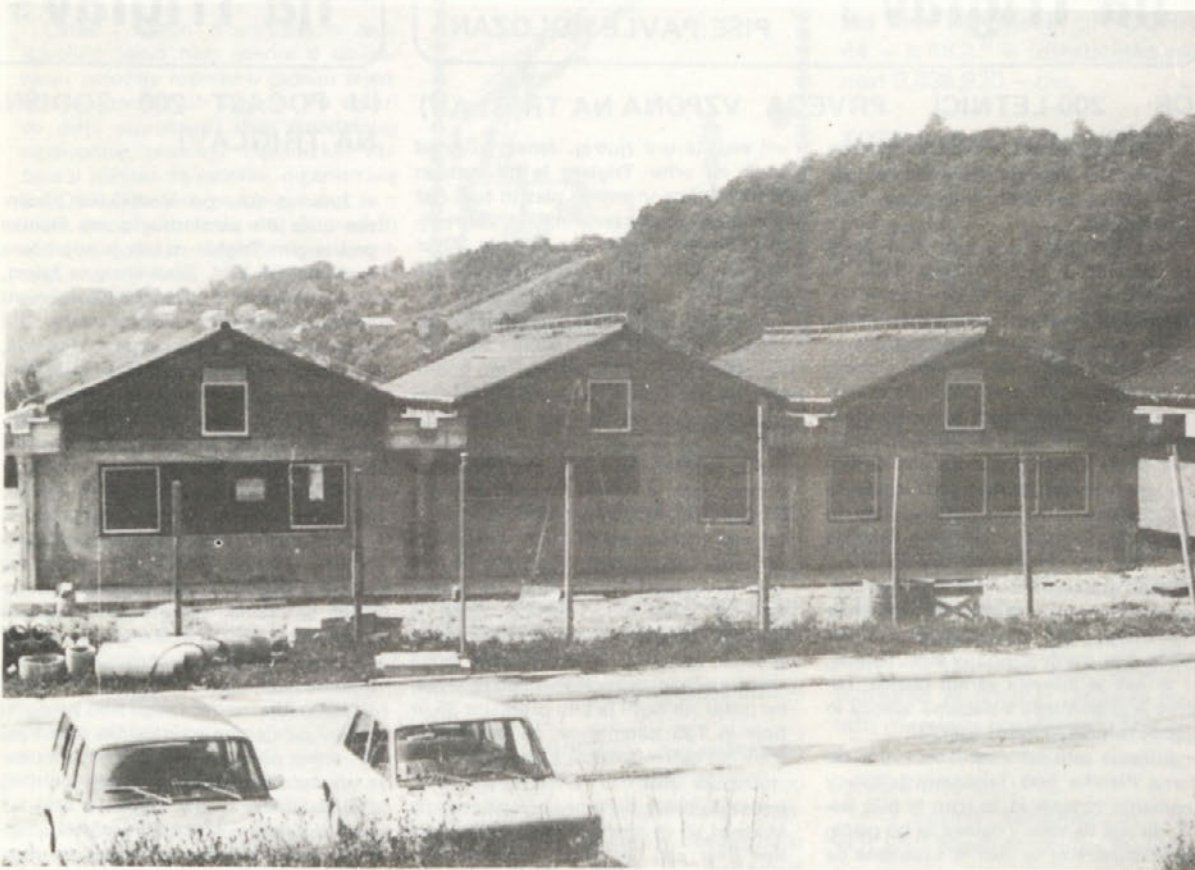
Gradnja druge faze otroškoga vrtca v Krškem (FOTO: Goran Rovani)
