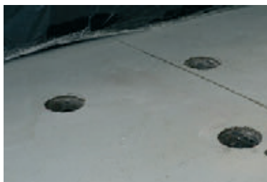
» Slika 14: Izvrtine za pozicionirna gnezda
