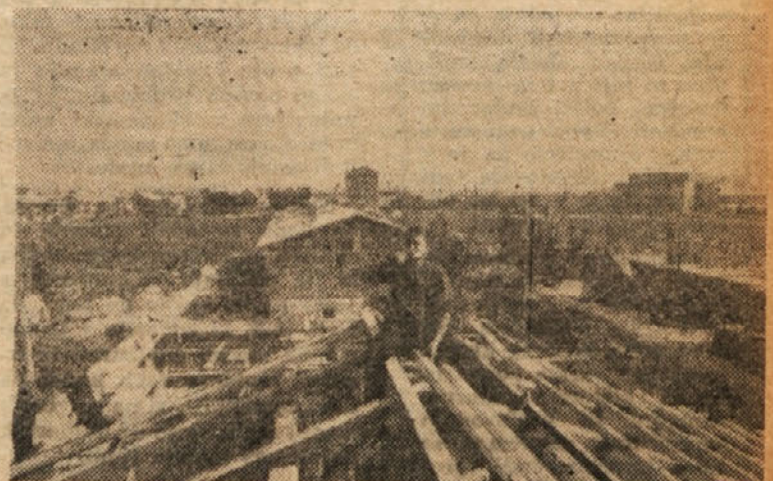
Dvajset članov našega kolektiva je letos pričelo graditi stanovanjske hiše na Hudinji. Prvi med njimi so ostrešje že pokrili. Na sliki: ko je ostrešje »zvezano«, se prileže tudi požirek domačega.
