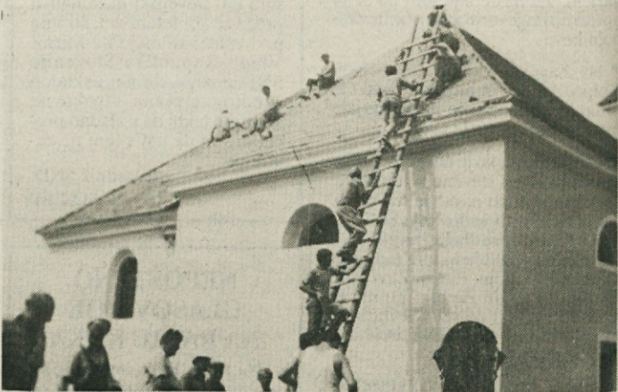
NOVA STREHA - Čeprav je bila streha župnijske cerkve sv. Martina v Podzemlju potrebna popravila, v župniji niso imeli denarja. Zato so se farani odločili, da sami zberejo denar ter pomagajo z delom in pri prehrani delavcev. Niso pripravili nikakršne posebne zbiralne akcije, temveč je vsak faran prostovoljno prispeval, kolikor je bilo v njegovi moči. Tako so v začetku preteklega tedna začeli s prekrivanjem strehe z bobrovcem. Na udarniških akcijah se jih je zbralo po nekaj deset, vsak dan pa so prišli iz ene soseske. Načrtujejo, da bodo do birme v prihodnjem letu obnovili še fasado. (Foto: M.B.-J.)
