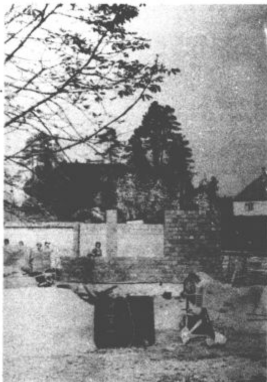
Gradnja novega kulturnega doma v Nazarjah je stekla in hitro napreduje. Graditelji zagotavljajo, da bo zagotovo zgrajen v predvidenem roku, če le ne bo večjih nepredvidenih težav.
