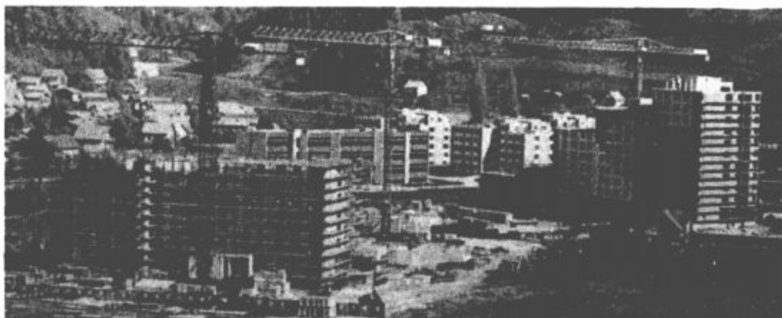
Jesenski pogled na gradbišče Šalek II.
